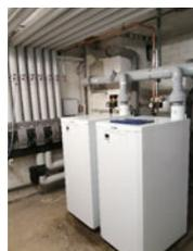
Noch vor Beginn der Heizperiode konnte die Erneuerung der Heizungsanlage im Sozialgebäude abgeschlossen werden. Nach über 30 Jahren wurde die vorhandene Ölheizung durch eine Flüssiggasanlage ersetzt. Aufgrund der Gebäudesubstanz, der verschiedenen Nutzungsarten und der verbauten Hochtemperaturabnehmer, war der Einbau alternativer
